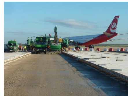
Flughafen Düsseldorf, Sanierung TWY L7
